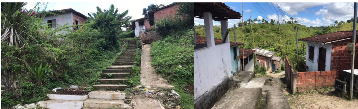
Figura 3. Ocupações irregulares e desordenadas no Loteamento Santa Rita no município de Nazaré-BA.
